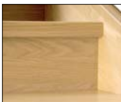
Eksempel på tett trapp
